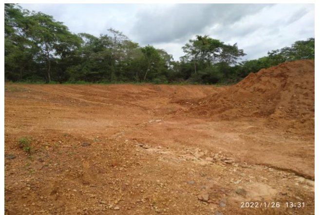
Foto Nº 06 - Local da Jazida - Loc. Porteira
