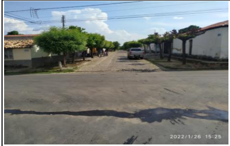
FOTO Nº 1 - INÍCIO DO TRECHO : RUA RUI BARBOSA - TRECHO 02
