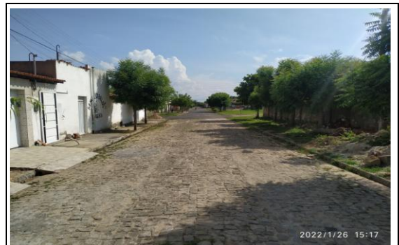
FOTO Nº 6 - RUA RUI BARBOSA - TRECHO 01
