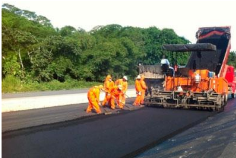
FIGURA 3: APLICAÇÃO DO CONCRETO ASFÁLTICO
