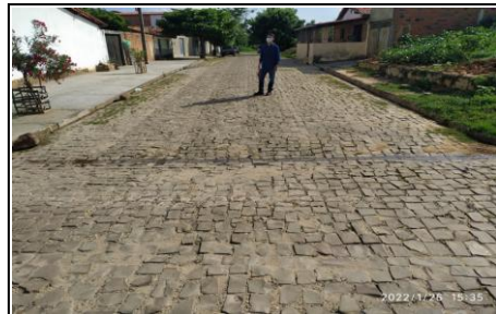
FOTO Nº 4 - RUA RUI BARBOSA - TRECHO 02
