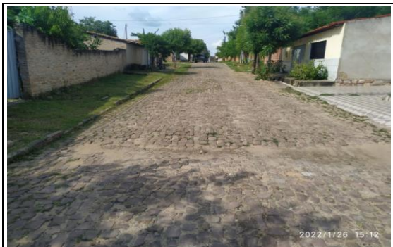
FOTO Nº 5 - RUA RUI BARBOSA - TRECHO 01
