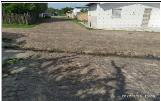
FOTO Nº 3 - RUA RUI BARBOSA - TRECHO 01
