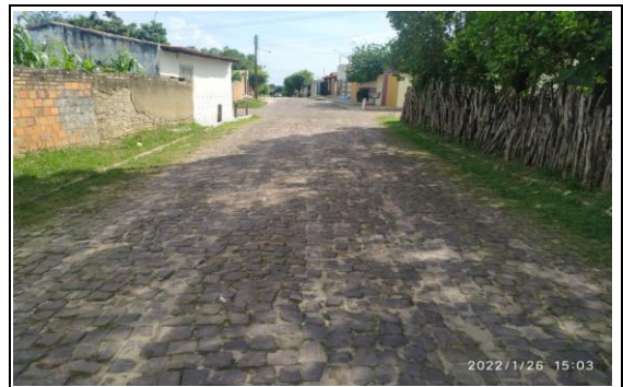
FOTO Nº 2 - RUA RUI BARBOSA - TRECHO 01
