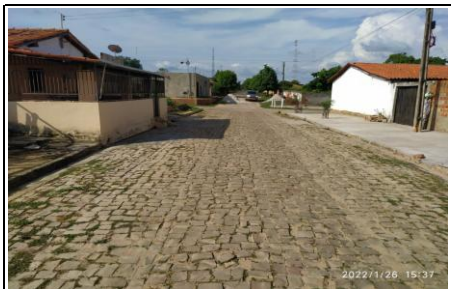
FOTO Nº 5 - RUA RUI BARBOSA - TRECHO 02
