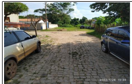
FOTO Nº 6 - RUA RUI BARBOSA - TRECHO 02
