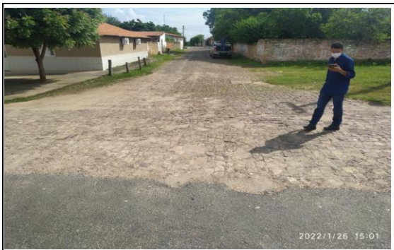
FOTO Nº 1 - INÍCIO DO TRECHO : RUA RUI BARBOSA - TRECHO 01
