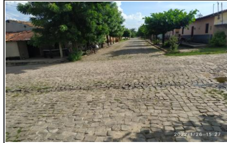
FOTO Nº 2 - RUA RUI BARBOSA - TRECHO 02
