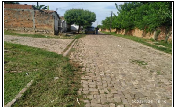
FOTO Nº 4 - RUA RUI BARBOSA - TRECHO 01
