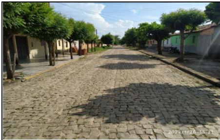
FOTO Nº 3 - RUA RUI BARBOSA - TRECHO 02
