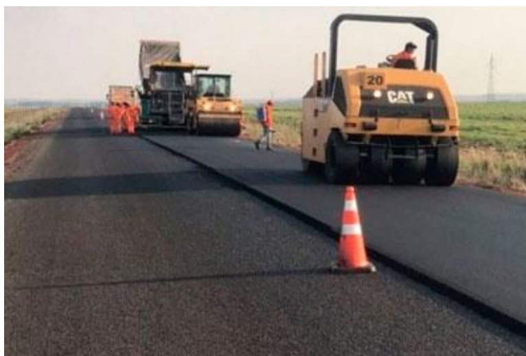
FIGURA 4: COMPACTAÇÃO DO CONCRETO ASFÁLTICO
