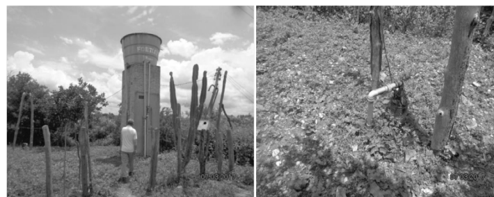
Figura 52 – Poço 1 – Reservatório, quadro de energia e poço – SAA Isolado Buriti 3 (Bairro Vaquejada)
