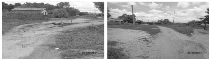
Figura 72 – Ponto de erosão na Rua Luiz de França – Bairro Cipaíba
