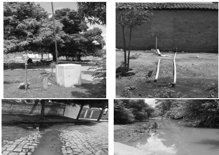
Figura 5 – Visitas técnicas às estruturas e equipamentos de saneamento no município
