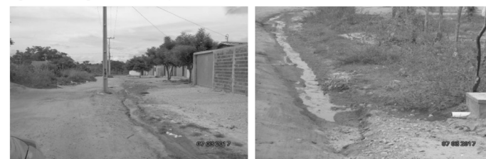
Figura 68 – Esgoto sendo lançado na Rua do Assentamento
