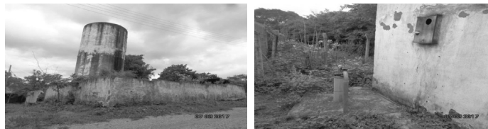
Figura 42 – Reservatório de concreto (capacidade de 65m³) e poço 6 – SAA Sede
