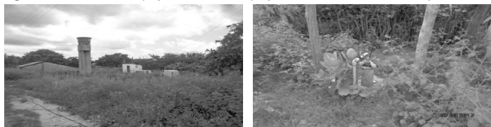
Figura 56 – Reservatório (capacidade de 5 m³) e poço – SAA Isolado Bairro Cipaúba
