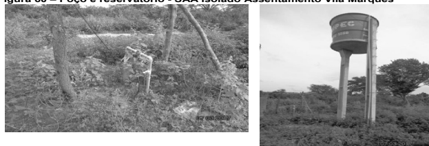
Figura 60 – Poço e reservatório - SAA Isolado Assentamento Vila Marques
