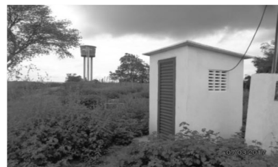
Figura 54 – Poço 2 – Abrigo do comando da bomba e reservatório – SAA Isolado Buriti 3 (Bairro Vaquejada)
