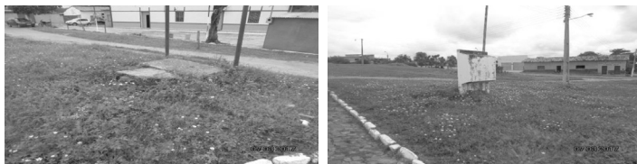
Figura 36 – Poço 2 (abaixo das placas de concreto) e quadro de comando da bomba – SAA Sede
